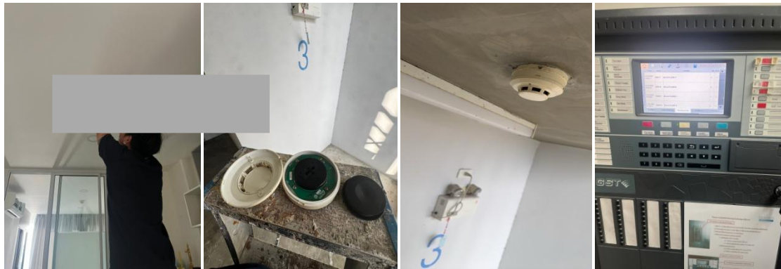
รูปที่ 2-21 การตรวจสอบระบบป้องกันและเตือนอัคคีภัย
